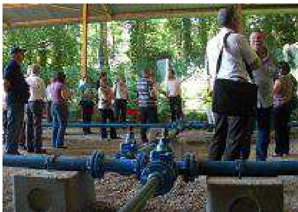
Réseau hydraulique – EPLEFPA de Vienne
