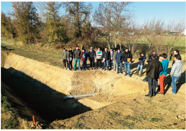
Visite du chantier de la zone tampon humide artificielle par les élèves de 1ère Bac pro Agroéquipement chargés du suivi du dispositif et des agriculteurs locaux.
